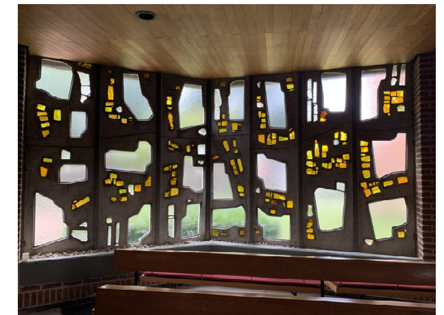
FARBIGE BETON-GLASELEMENTE WEITERHIN VOM KIRCHENRAUM SICHTBAR
